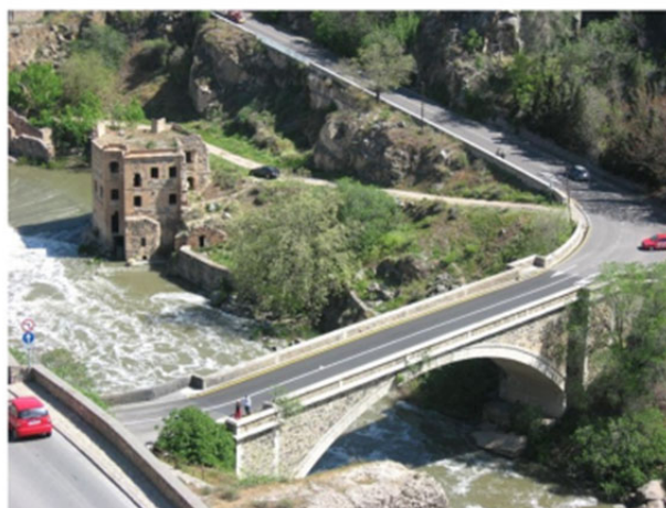
新アルカンタラ橋
