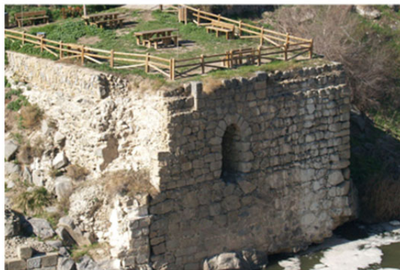
トレド ローマ期水道橋
